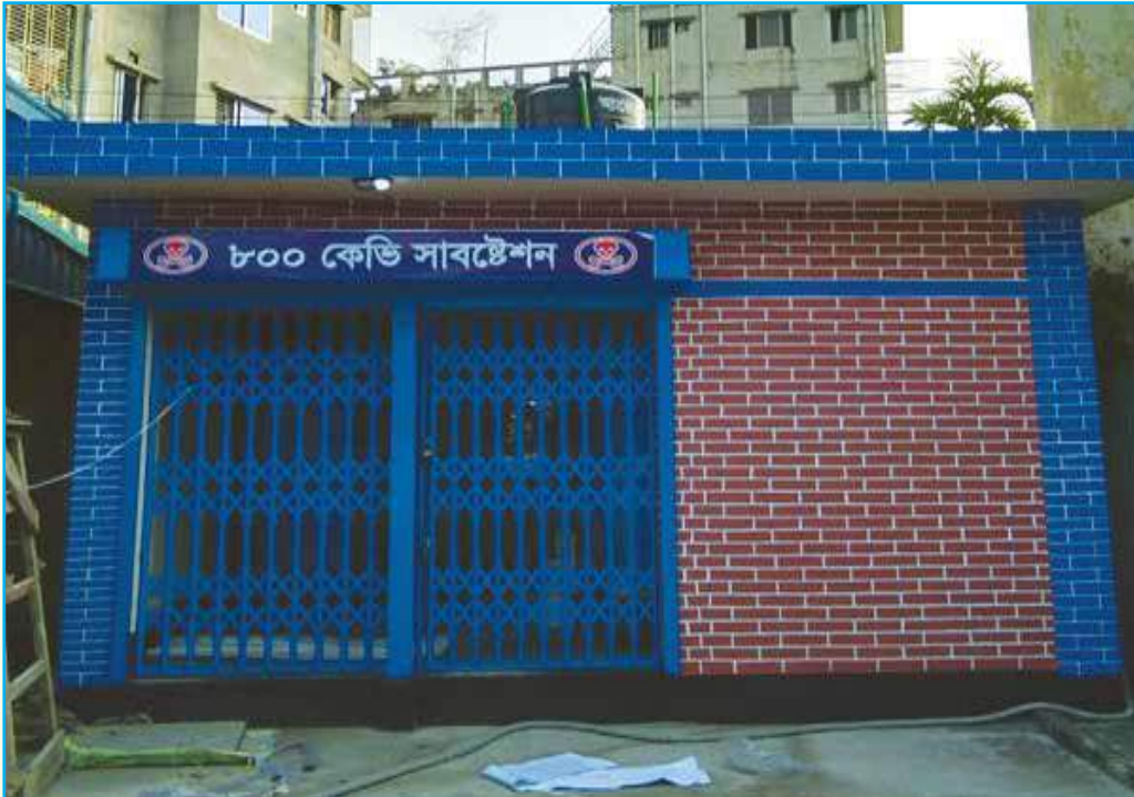
নবনির্মিত ৮,০০০ বর্গফুটের একটি আধুনিক ইন্ডাস্ট্রিয়াল সেডমৈত্রী শিল্পে নবনির্মিত ৮০০ কেভিএ আধুনিক বৈদ্যুতিক সাব-স্টেশন
